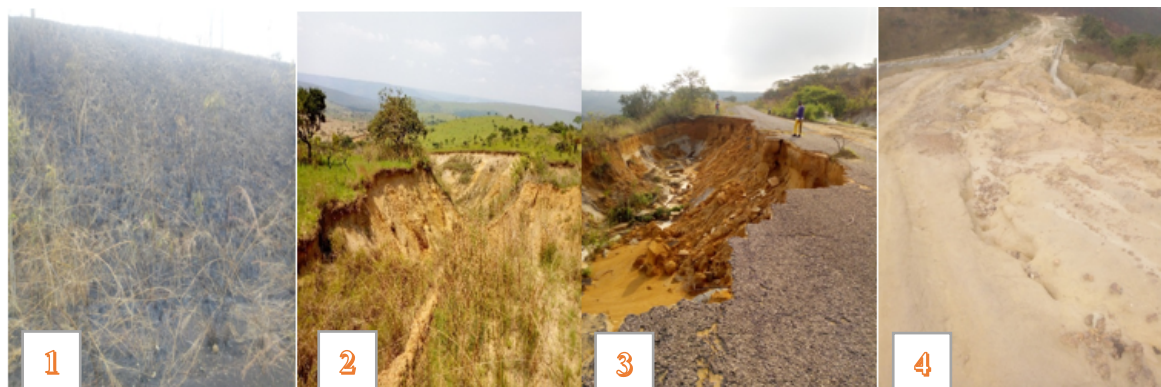
Photo N°1 : Feux de brousse sur talus de remblais ; Photo N°2 : Dégradation de l'environnement ; Photo N°3 : Destruction d'une partie de la route faute de collecteur d'eau pluviale ; Photo N°4 : Rigoles et ravines sur une voie abandonnée
